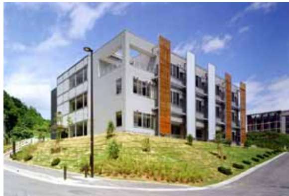
<京大桂ベンチャープラザ外観>
